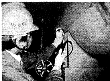
図3 機器脚付根部の肉厚測定状況
