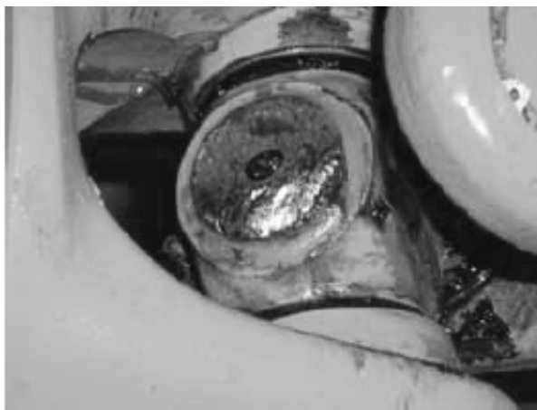
写真-3 6号機天井クレーン走行伝動用南側継手部の破損 [4]
