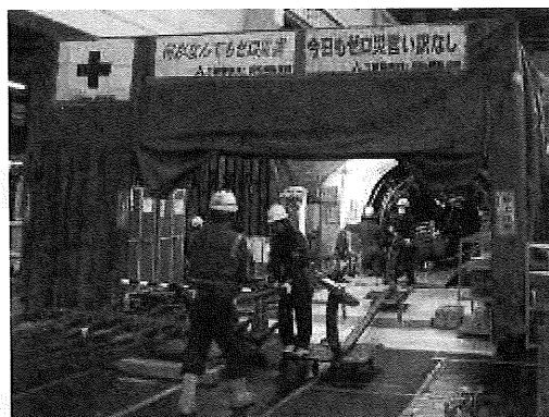
図1 タービン発電機リフレッシュ工事 (固定子コイル巻替工事)
