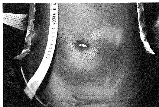
図 2 配管内面の状況
