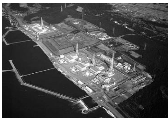
図1 柏崎刈羽原子力発電所
