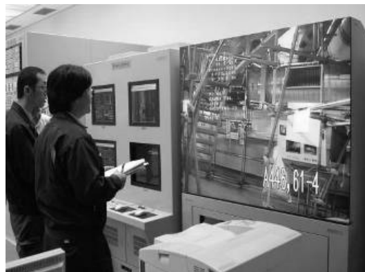
図3 ナトリウム総合漏えい監視システム
