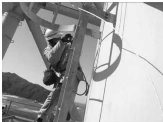
図4 屋外排気ダクト外面点検
