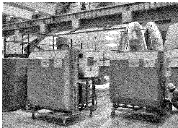
Fig. 11 タービン車室接続状況
