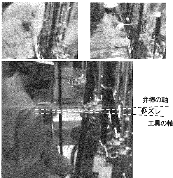
図2 現状工具を用いた弁操作の状況
