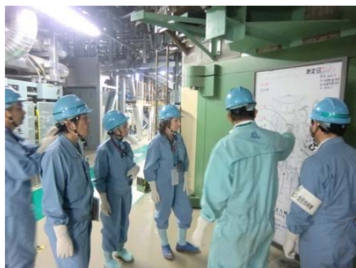
図6 現地調査 (1号原子炉建屋)
