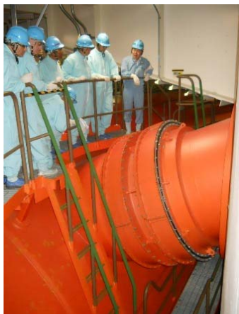
図4 現地調査（2号原子炉格納容器）
