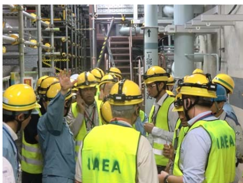
図5 浸水調査（2号原子炉補機冷却水系熱交換器0室）
