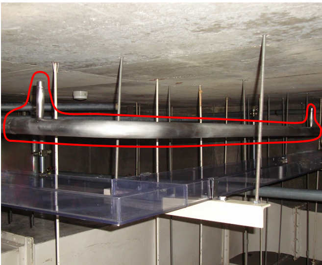
図 11 W004 排水配管復旧箇所
