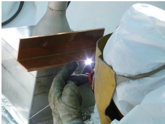
図 13 溶接部の近傍に銅板を設置し TIG 溶接を実施
