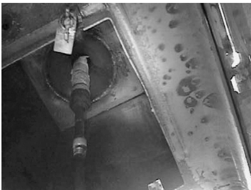
図8 排気用フィルターケーシング内部の除染の様子
