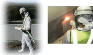
図1 塗膜除去用に開発されたポータブルレーザー照射装置
