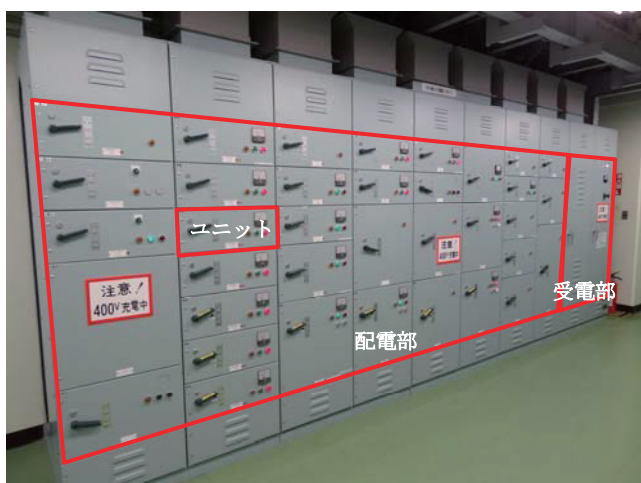
図2. モーターコントロール型動力分電盤の外観
