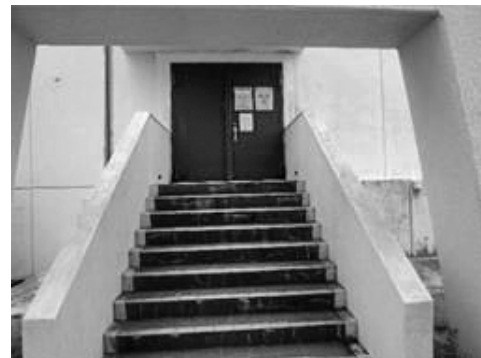
図7 非常用扉外観
