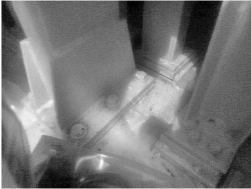
図11 CCDカメラによる基礎ボルト点検
