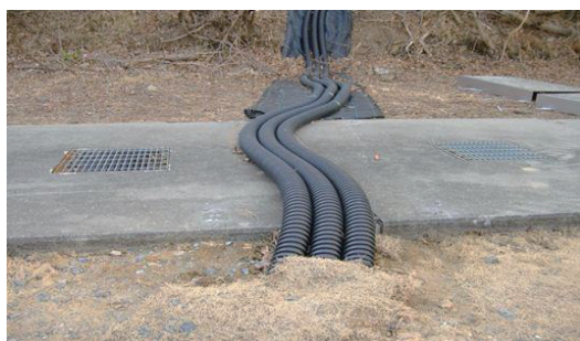
Fig7. ケーブルスネーク施工
