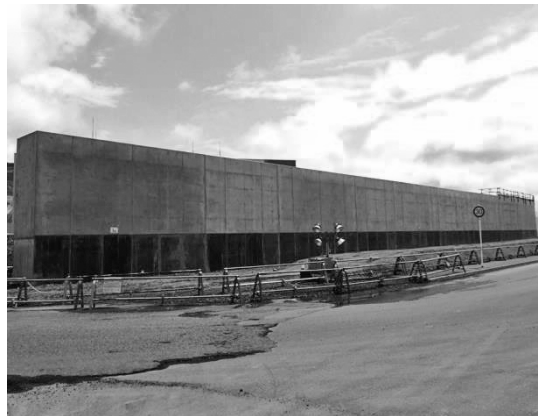
図10 防潮堤（擁壁区間）
