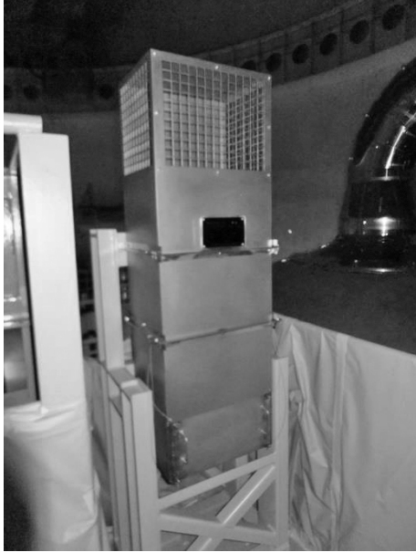
図7 静的触媒式水素再結合装置
