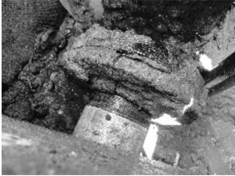
写真1 漏水箇所の状況
