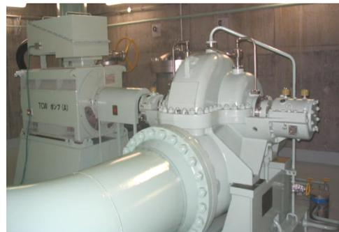
図9 1号機タービン補機冷却水ポンプ
