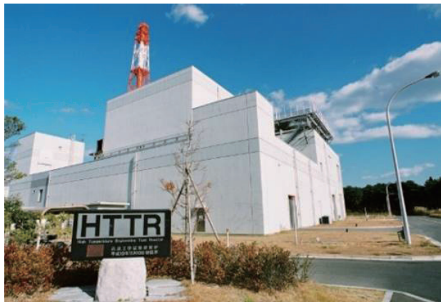
図1 HTTR原子炉建家外観
