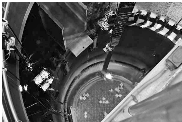
図3 Hatch 発電所における ATF 試験燃料体の装荷の様子 (NRC web サイトから) [7]
