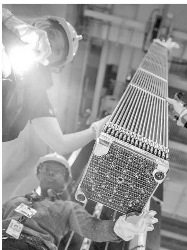
図4 Vogtle 発電所における試験燃料集合体の装荷の様子 (Southern Nuclear web サイトから) [8]
