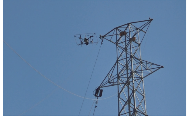
図 3 架空地線自動撮影状況
