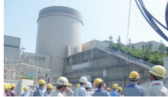
図10-1 32m構台設置前の高台
