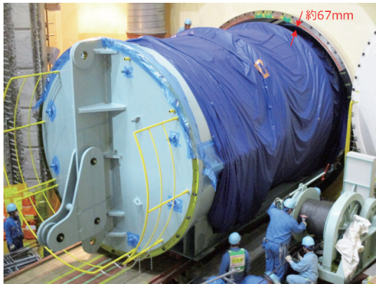
図4 新炉内構造物の搬入
