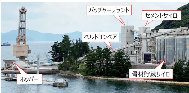
図14 バッチャープラント等の概要
