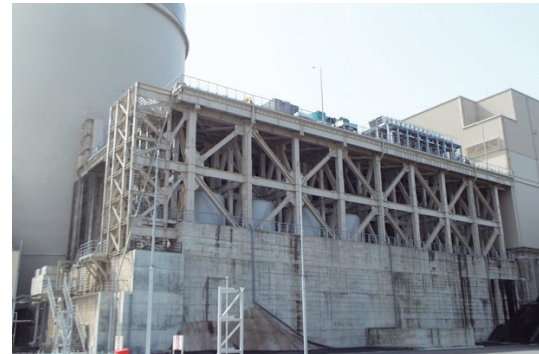
図10-3 32m構台完成
