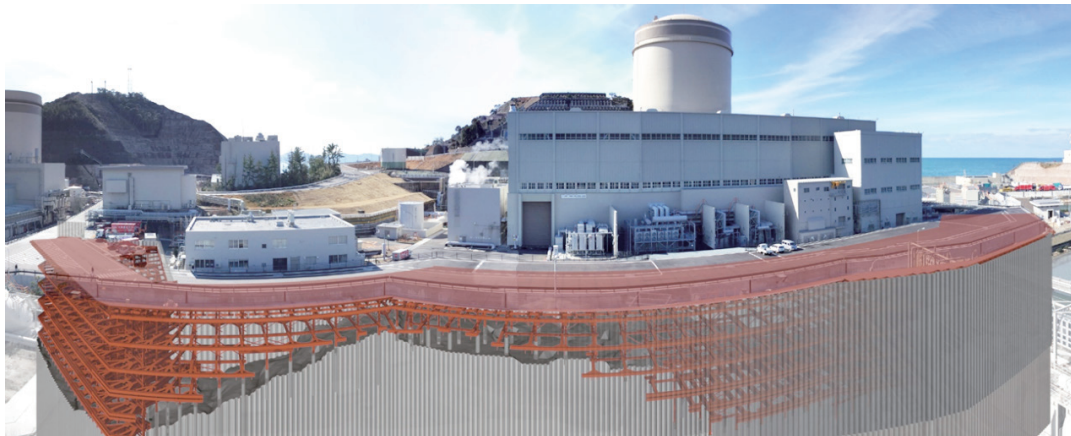
図12-2 防潮堤の構造
