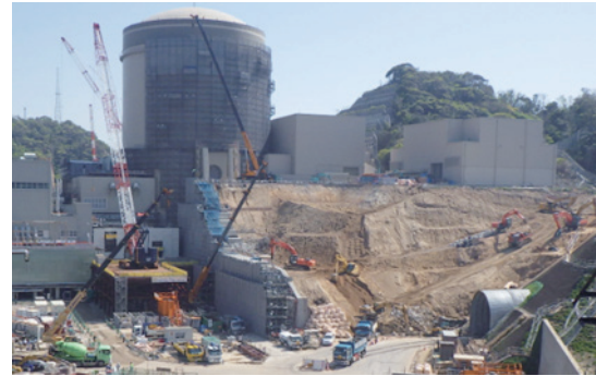
図10-2 32m構台設置工事中
