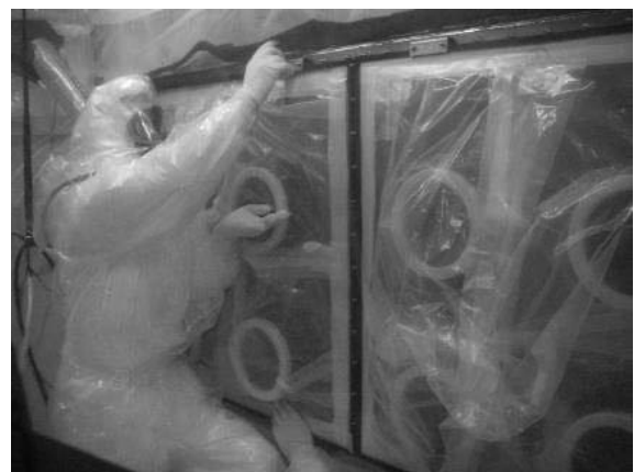
図8 新パネル取り付け作業時の様子
