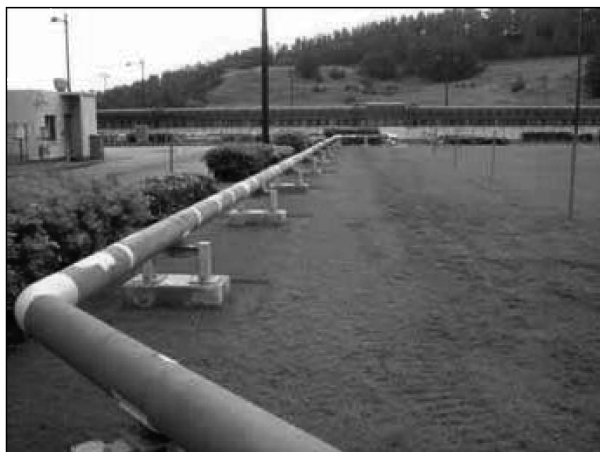
図 10 屋外消火栓配管の地上化
