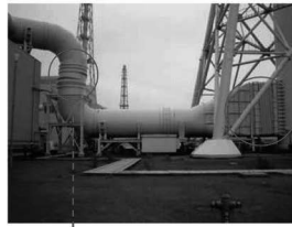
K1 排気ダクト外観
