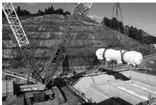
図2 タンク吊り下し状況
