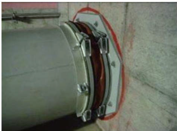
Fig.5 水密シールとしての配管ブーツの設置例
