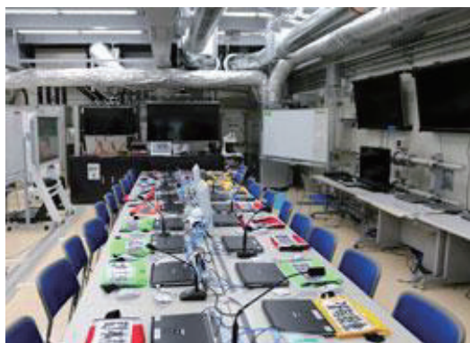
図 2 5 緊急時対策所 (内観)
