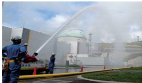
図 21 放水砲による放水（訓練時）
