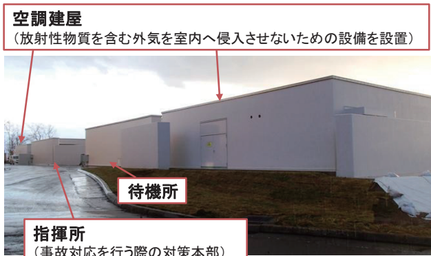
図 2 4 緊急時対策所 (外観)
