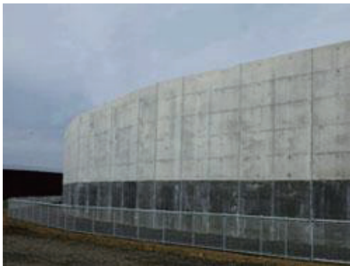
図3 防潮堤（鉄筋コンクリート壁部）
