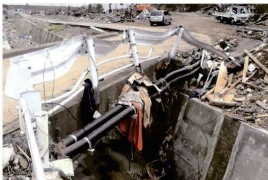
図9 東日本大震災時のポリエチレン管 (泊発電所では今後敷設予定)
