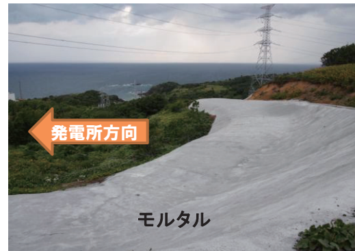
図6 防護帯のモルタル吹き付け状況
