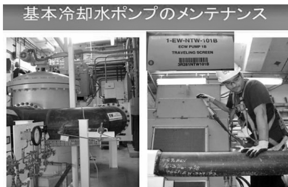
図 9 最終ヒートシンクの冷却ポンプの OLM 事例
