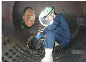
図1 ボイラ伝熱管の検査作業の様子
