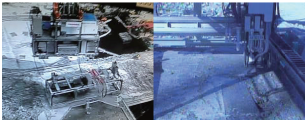
図6 高圧水はつり装置
