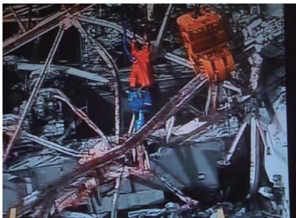
図2 大型がれきの遠隔切断状況
