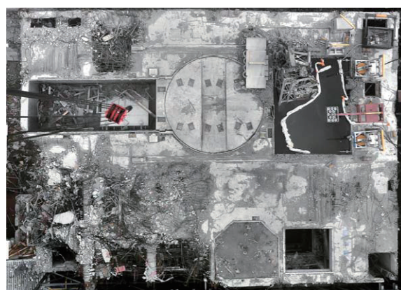
図3 がれき撤去後のオペレーティングフロア
