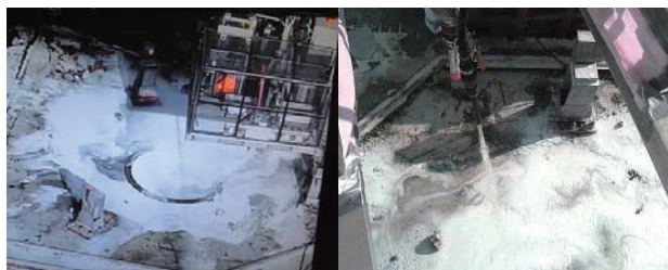
図7 化学(泡)除染の状況
