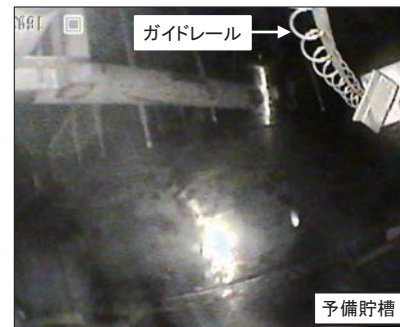
図4 予備貯槽全体の状態観察 (貯槽上部のガイドレールより撮影)
