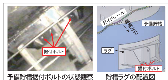
図7 据付ボルトの状態観察
