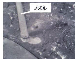
③ 回収装置によるせん断粉末等の回収
