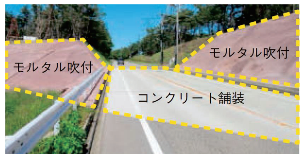
図8 防火帯(モルタル吹付状況)
