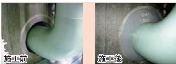
図10 配管貫通部のシーリング補強
