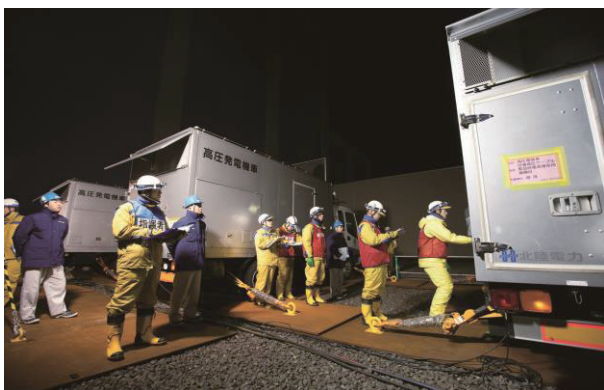
図 15 夜間の電源接続訓練
