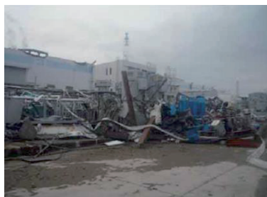
図1 漂流物衝突の影響 [1] (福島第一原子力発電所 循環水ポンプ)
