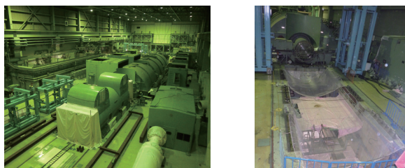
図4 浜岡2号機発電機の解体前後の状況
