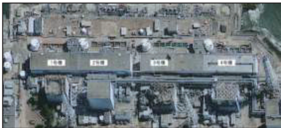
図1 福島第一原子力発電所
