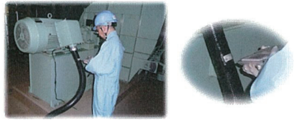
図5 現場でのバーコードリーダーによる作業実施状況の例
