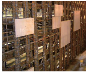
図1 埋込金物据付状況
