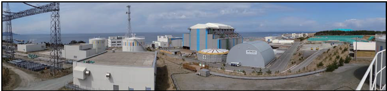
図1 大間原子力建設所全景 (平成31年4月)
