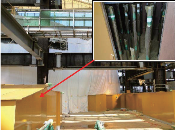
図5 鉄筋の養生 (原子炉建屋)
