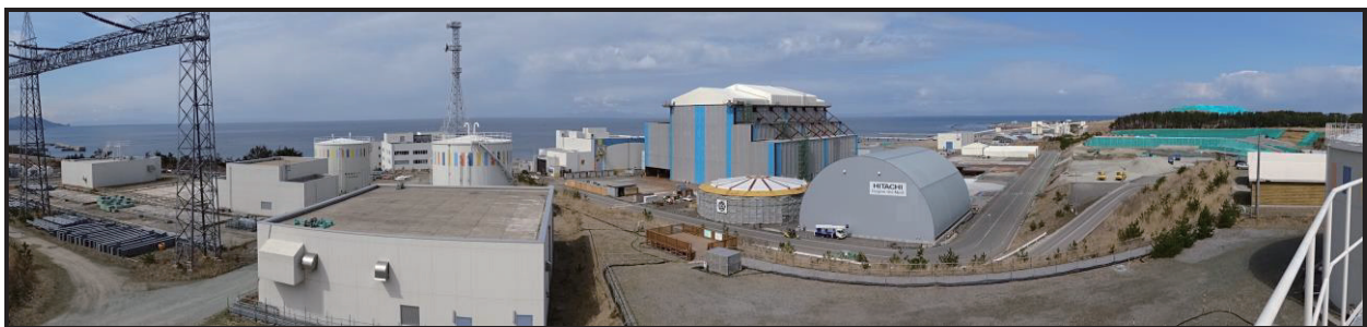
図1 大間原子力建設所全景 (2019年4月)
