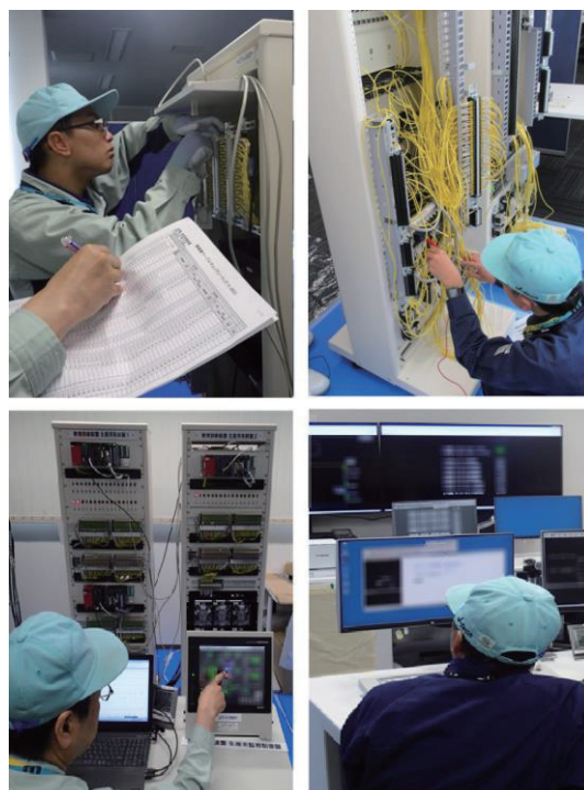
図17. 製作・試験作業状況
