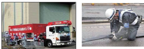
◇移動式大容量ポンプ車の設置 ◇冷却水供給（ホース繋ぎ込み）(雨天時)
