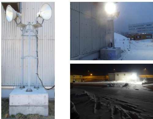
図4 照明設備完成品、点灯状況
