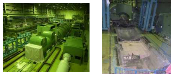
図2 浜岡2号機発電機の解体前後の状況
