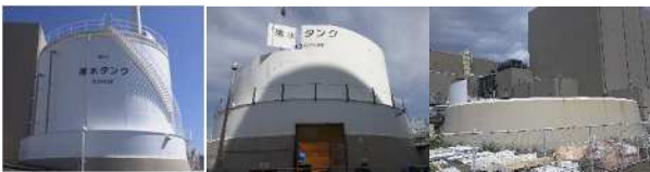
図4 浜岡1号機の復水タンクの解体状況
