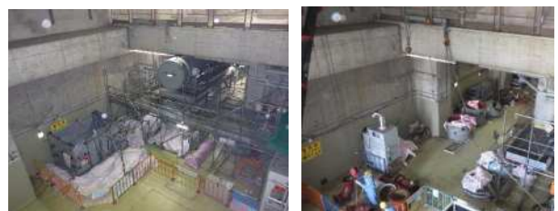
図3 浜岡1号機のタービン冷却設備の解体前後の状況
