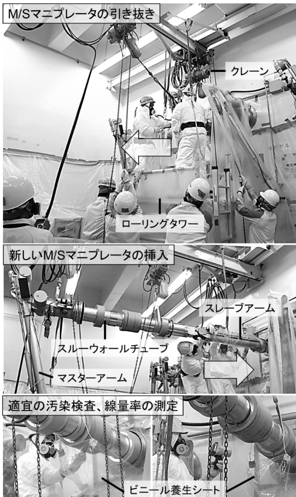
図5 M/S マニプレータの交換方法
