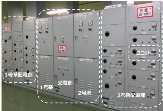
図 2. モーターコントロールセンタ型動力分電盤の例
