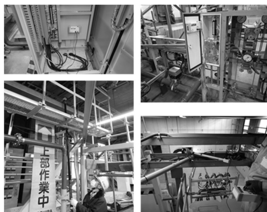
図7 ケーブルルート確認の状況
