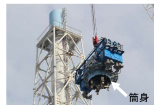
⑤ 吊り下ろし
