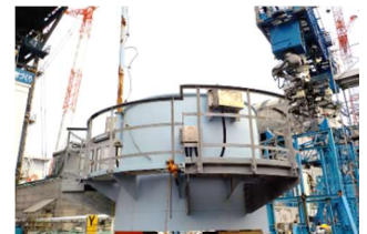
⑥ 解体部材
