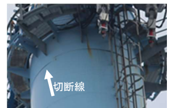
④ 排気筒切断(外側)
