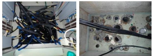
図4 中央制御室制御盤床下貫通ケーブルの解体撤去状況
