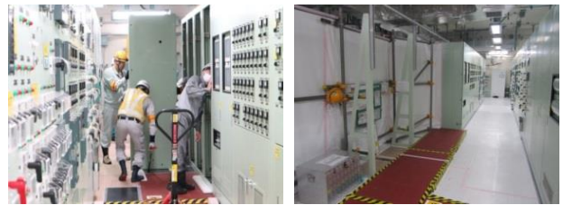
図3 中央制御室制御盤の解体撤去状況
