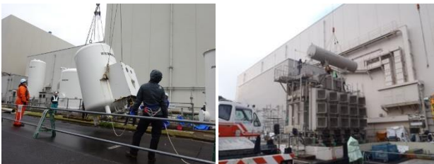
図2 窒素ガス制御系タンク(左)、主変圧器(右)の解体撤去状況
