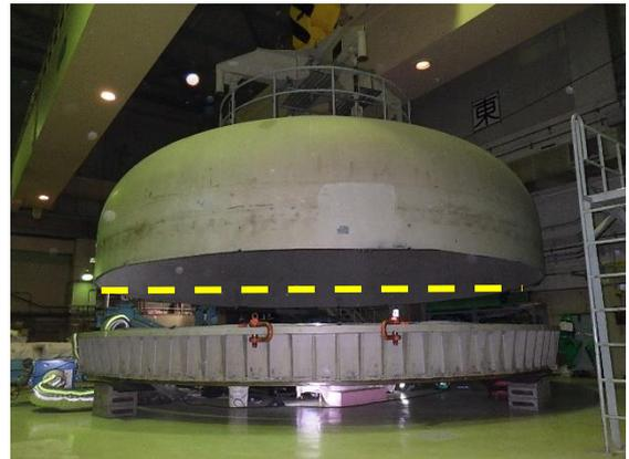
図5 格納容器上蓋の切断の様子（黄破線部で切断）
